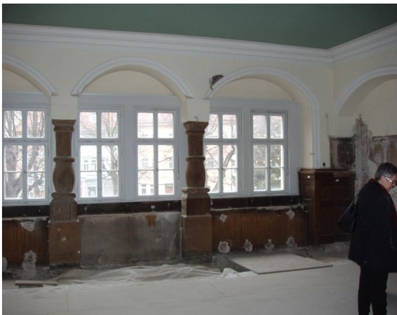
Rathausaal vor der Rekonstruktion 2009
